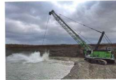
L'opérateur est aidé à la manœuvre par grâce au système de synchronisation automatique des deux treuils.
